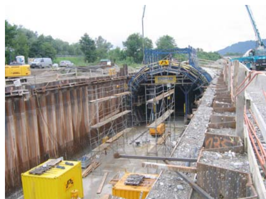
Betonieren des Tunnels
