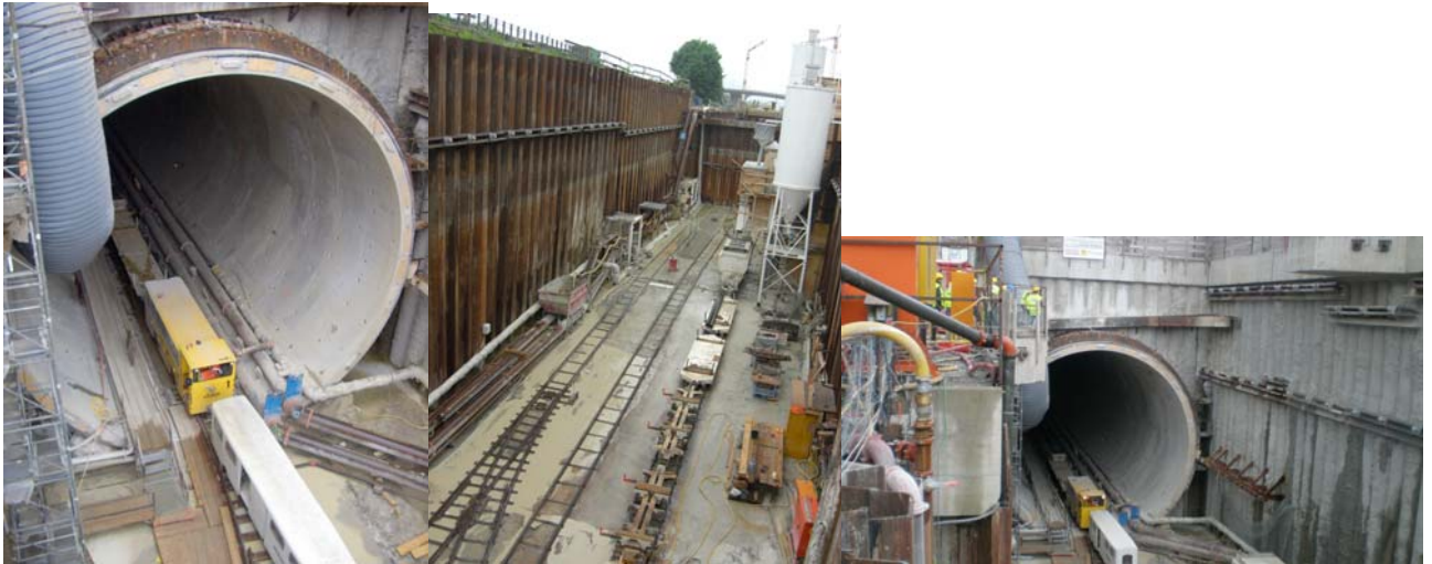
Einfahrt zur Vortriebsmaschine –
