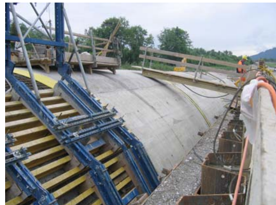
fertig betonierter Tunnel
