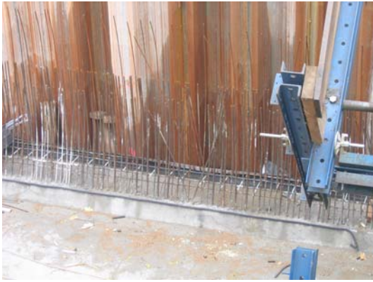
Anschlussbewehrung der Bodenplatte
