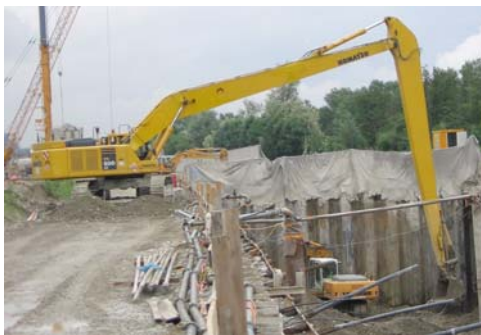
Ausbaggern der Sohle mit GPS – Bagger mit Auslegerlänge = 25 m
