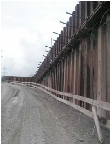
Der Einstieg ist mit einer verankerten Spundwand gesichert
