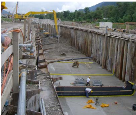
Der Graben wird ausgebuddelt und gegen Grundwasser geschützt
