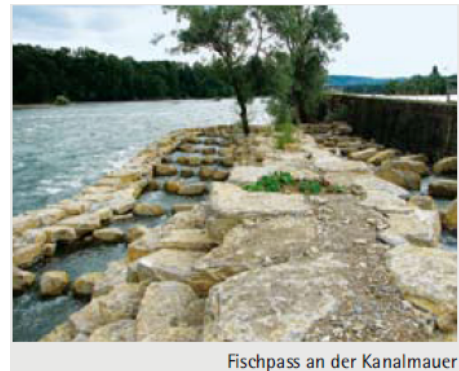
Fischpass an der Kanalmauer
